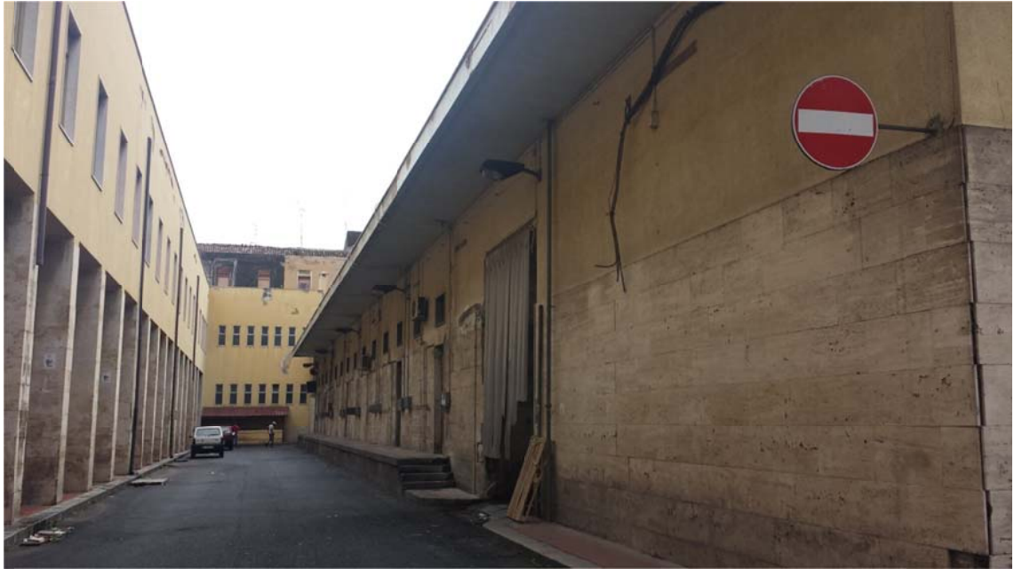
Figura 12: vista dal cortile interno fabbricato nr.4 a sx, fabbricato nr.2 a dx e fabbricato nr.1 sullo sfondo
