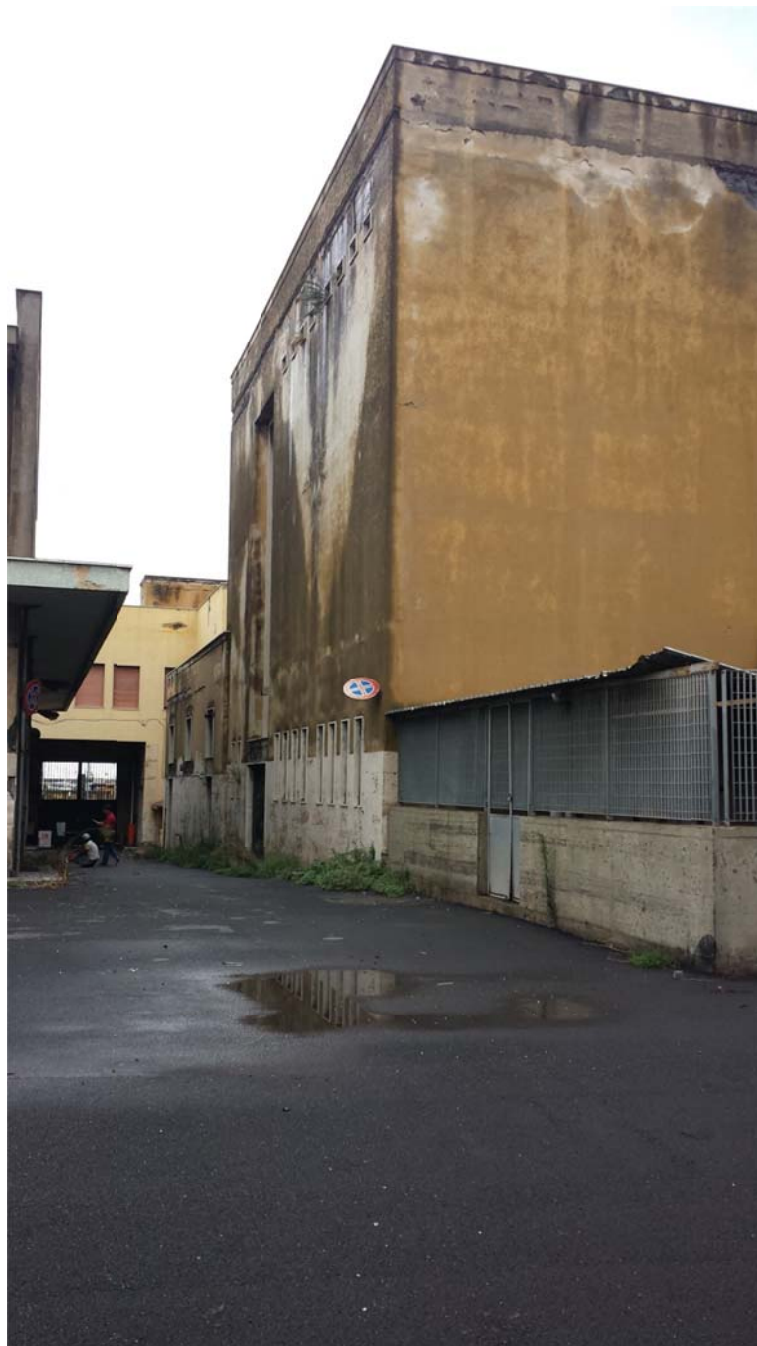
Figura 11: vista dal cortile interno fabbricato nr.1
