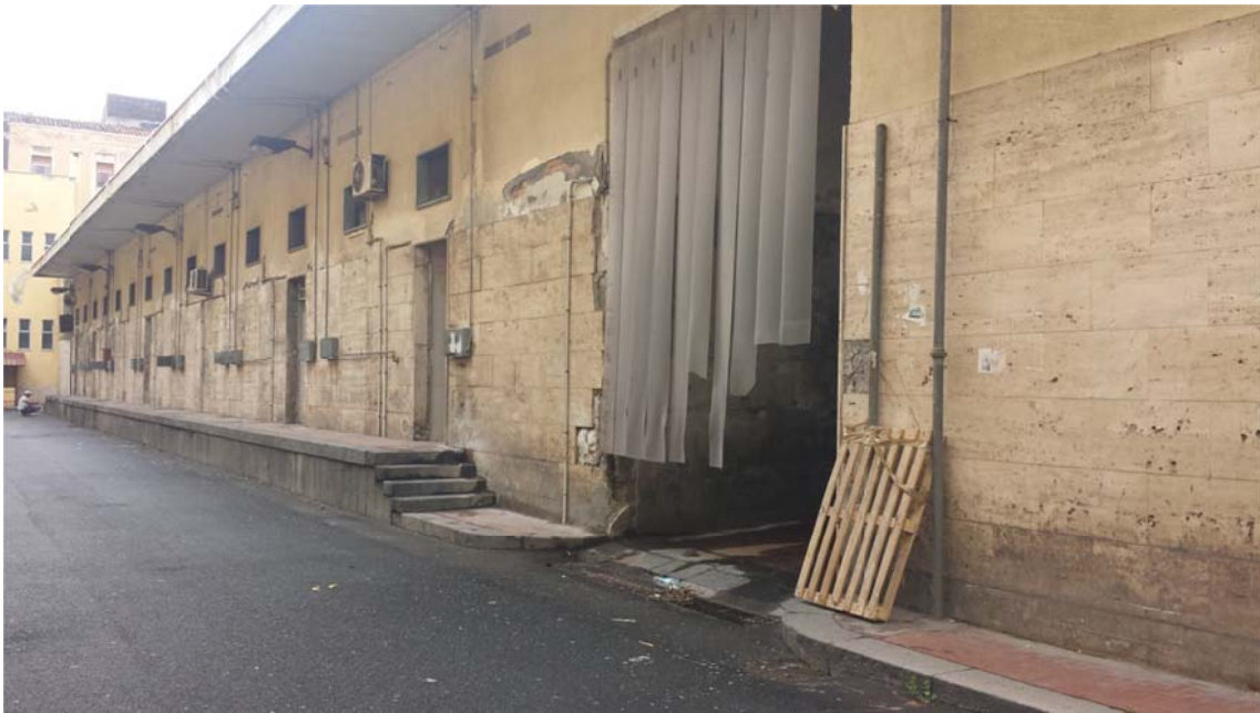
Figura 13: vista dal cortile interno fabbricato nr.2
