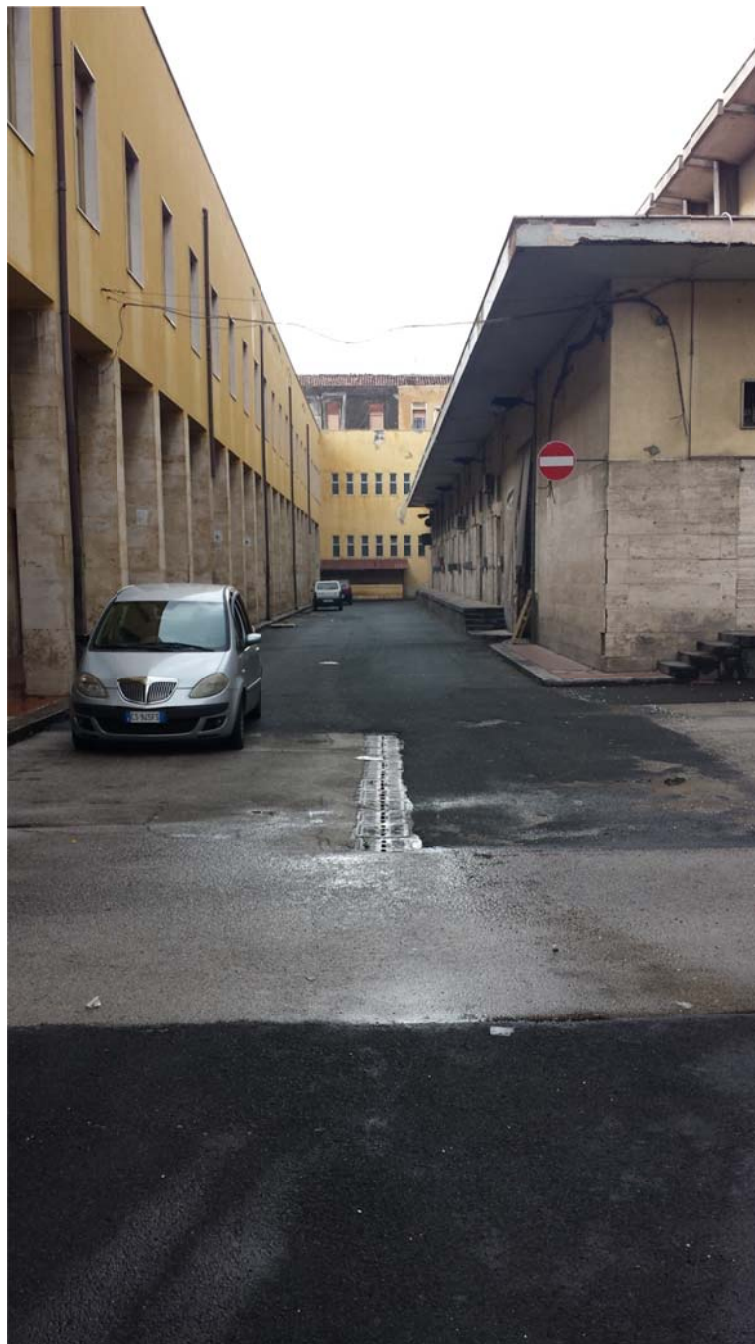
Figura 7: vista dal cortile interno fabbricato nr.4 a sx e fabbricato nr.2 a dx
