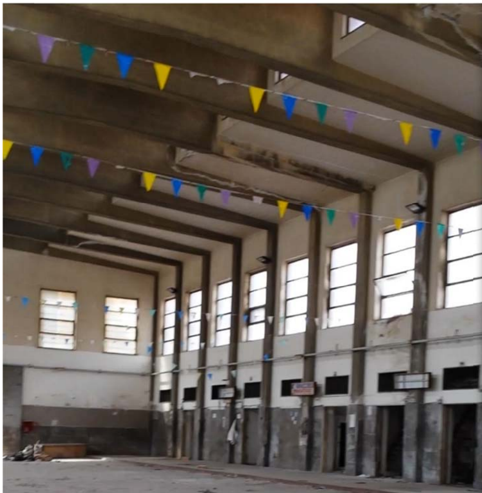
Figura 10: fabbricato nr.2 vista dall'interno
